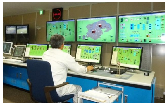
鶴ヶ島浄水場操作室
