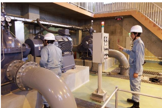
配水ポンプ設備点検
