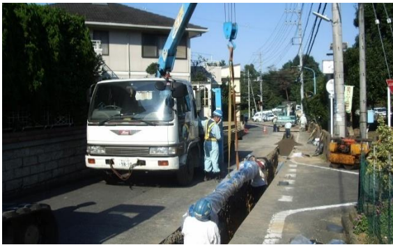
配水本管布設工事
