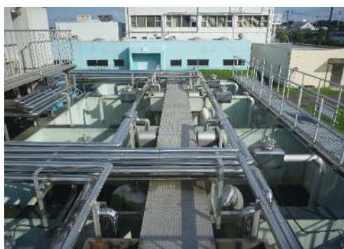
写真5 鶴ヶ島浄水場除鉄除マンガン装置
