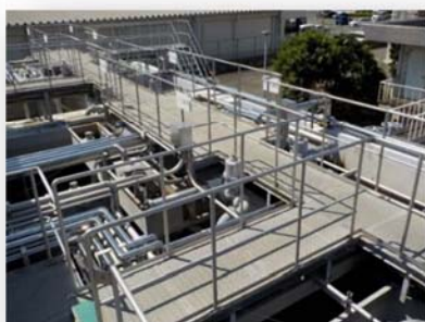
坂戸浄水場除鉄除マンガン装置
