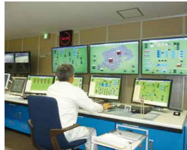
鶴ヶ島浄水場 監視制御システム
