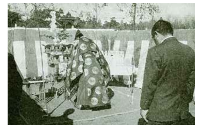
鶴ヶ島浄水場起工式
