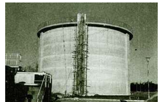
鶴ヶ島浄水場PC配水池
