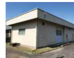
厚川取水中継ポンプ場
