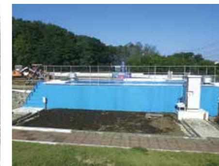
配水流量計室外観
