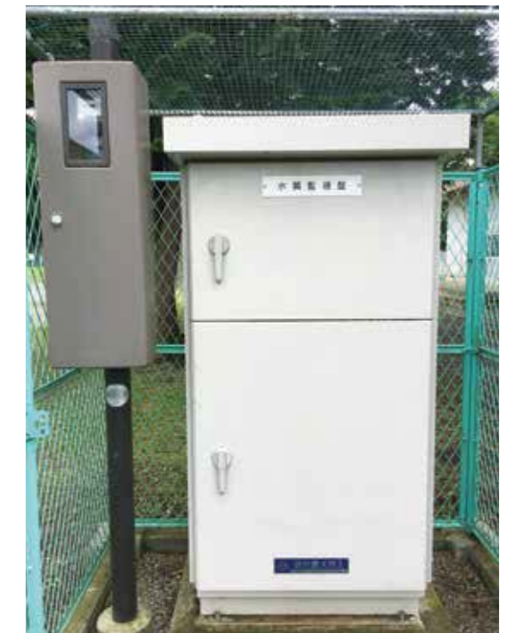
水質遠方監視装置
