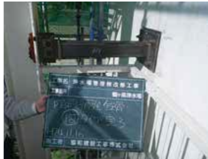
鶴ヶ島浄水場 鉄骨による外階段の耐震補強
