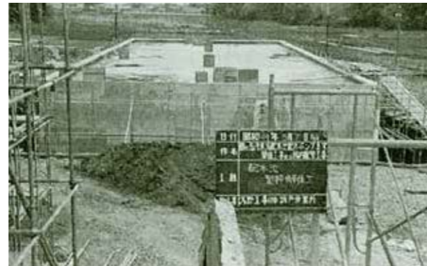
RC配水池建設工事
