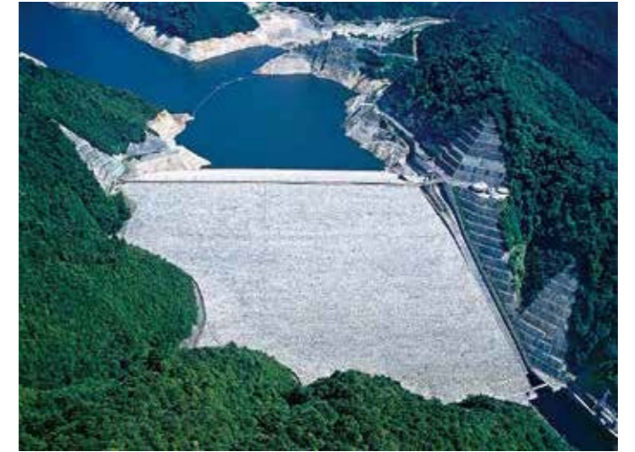
奈良俣ダム 総貯水量：9,000万 m ³ (水資源機構写真提供)
