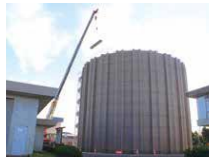
坂戸浄水場PC配水池
