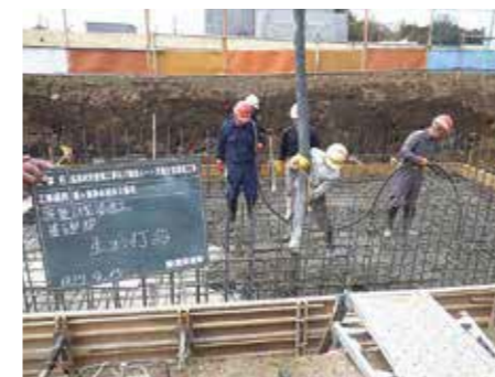
配水流量計室築造 生コン打設
