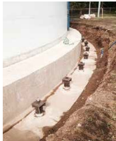
鶴ヶ島浄水場第2PC配水池 補強杭打込み完了後
