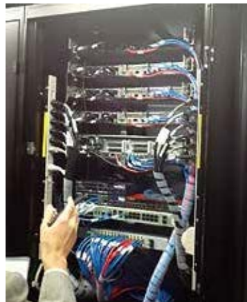
データセンター内に設置したサーバー群
