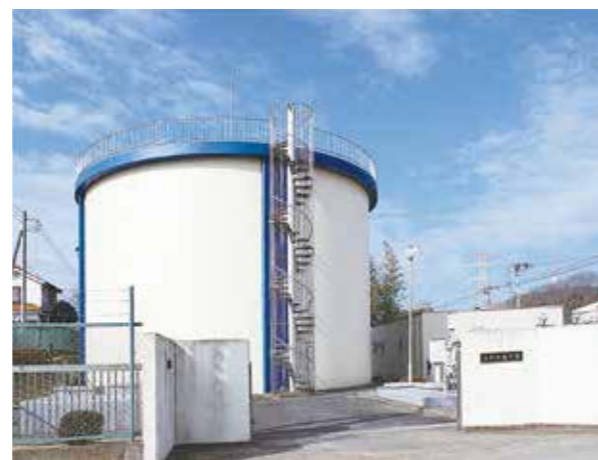
多和目配水場
