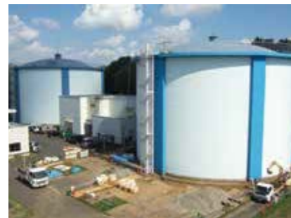
鶴ヶ島浄水場 第1・第2PC配水池
