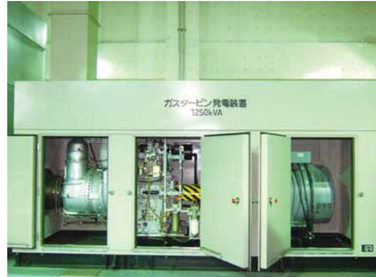
鶴ヶ島浄水場(第2発電機)
