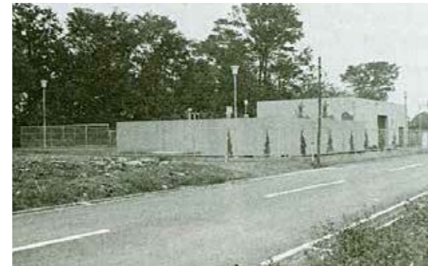
多和目中継ポンプ場
