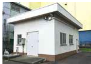
若葉台取水中継ポンプ場
