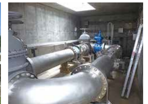
配水流量計室内
