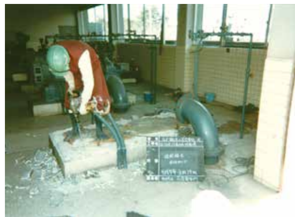
坂戸浄水場配水ポンプ工事
