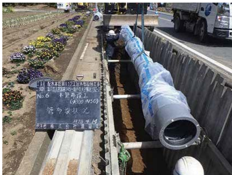
耐震管布設工事
