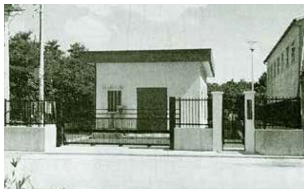
若葉台取水中継ポンプ場
