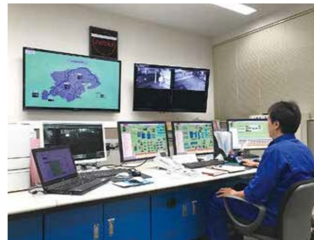
坂戸浄水場 監視制御システム
