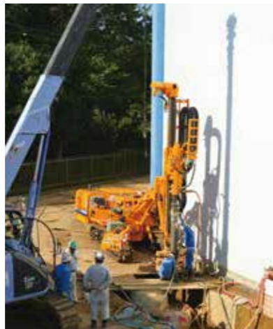
鶴ヶ島浄水場第2PC配水池 補強杭の打込み
