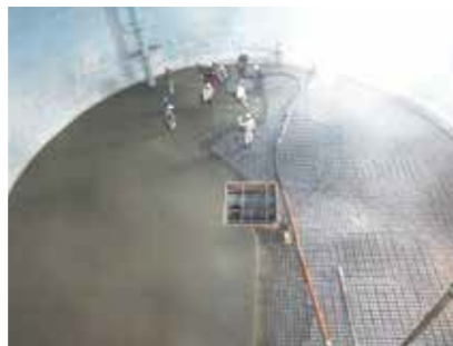
坂戸浄水場PC配水池 鉄筋コンクリートによる底板補強 (PC配水池内部)
