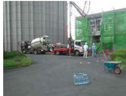
坂戸浄水場管理棟 耐震壁のコンクリート打設
