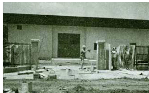
厚川取水中継ポンプ場
