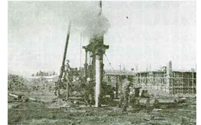
除鉄除マンガン装置建設工事
