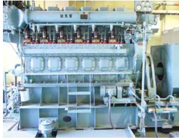
鶴ヶ島浄水場(第1発電機)
