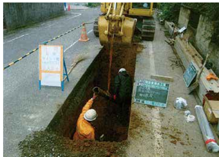
石綿セメント管の撤去工事
