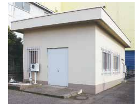
若葉台取水中継ポンプ場
