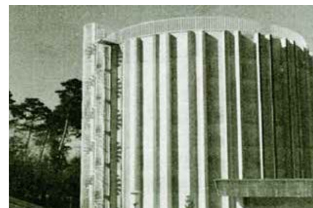
坂戸浄水場PC配水池
