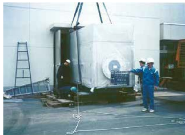
鶴ヶ島浄水場第2発電機室工事
