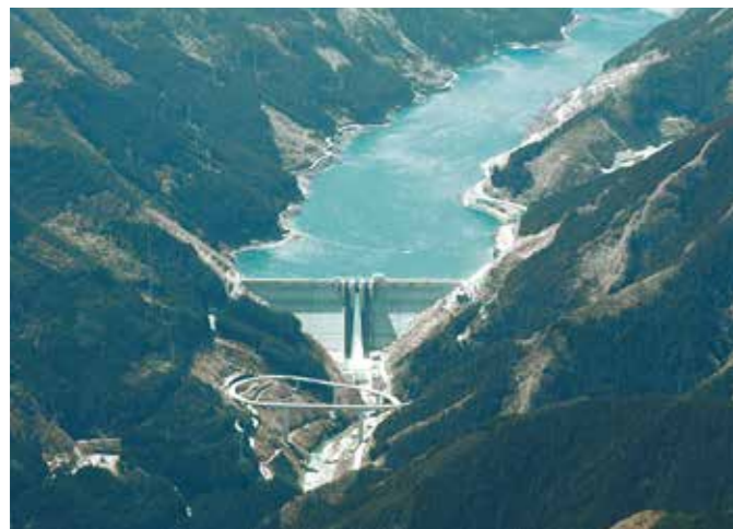
滝沢ダム 総貯水量：6,300万 m ³ (水資源機構写真提供)
