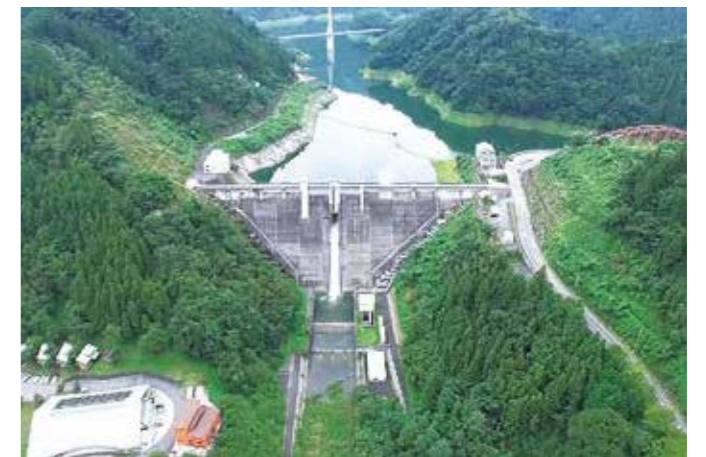
合角ダム 総貯水量：1,025万 m ³ (埼玉県秩父県土整備事務所合角ダム管理所写真提供)
