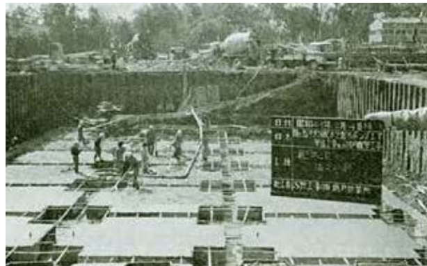
RC配水池建設工事
