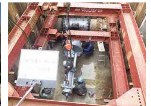
口径700mm 不断水割 T字管設置
