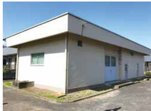
厚川取水中継ポンプ場
