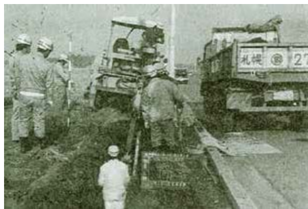
配水本管布設工事
