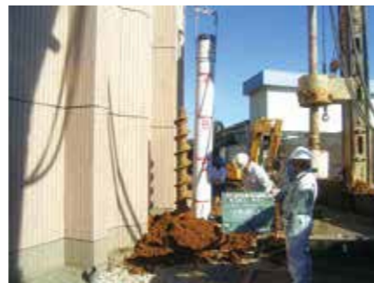
坂戸浄水場PC配水池 補強杭の打込み
