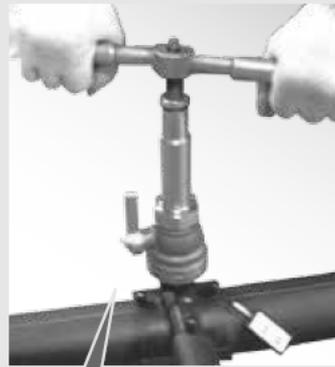
穿孔機にハンドルを差し込み蝶ネジを締め、右回転させて穿孔してください。ポリ本管に水圧が負荷されている場合は、サドル融着完了から30分以上経過後、穿孔してください。穿孔が始まると穿孔機の切片押し棒が上昇します。穿孔はハンドルが当たるネジ最下部まで確実に実施してください。その後ハンドルを左回転させ、キリを最上端まで引上げた後、バルブを閉めてください。(回転中、通水によりネジ部より水が出ます)
